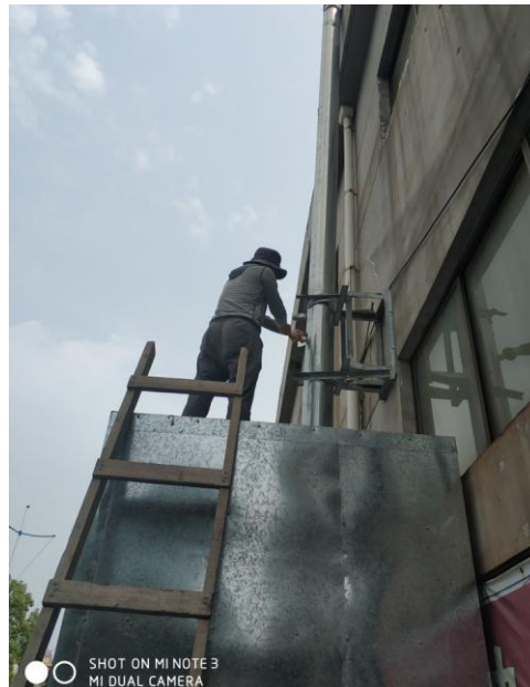
（活性炭处理设施）
