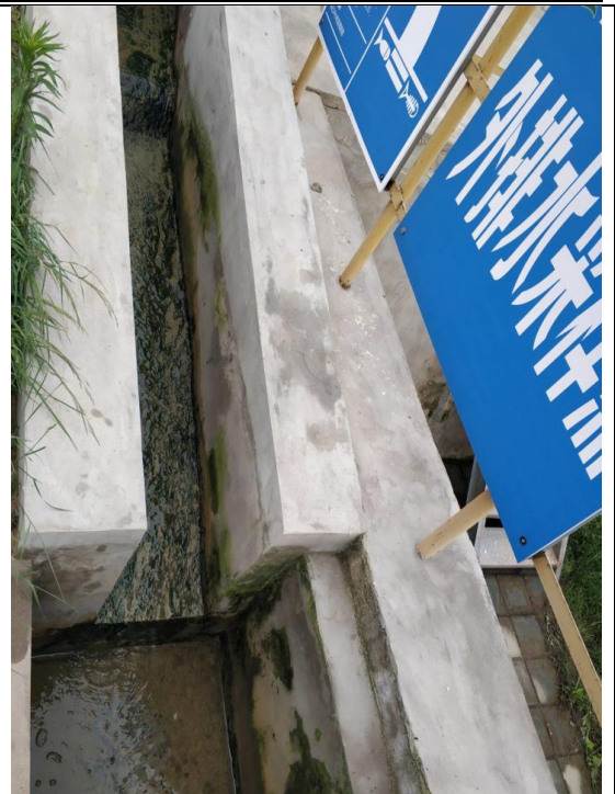
废水排口监测图片
