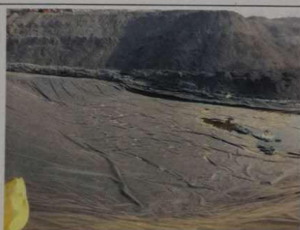
HDPE 膜的铺设
