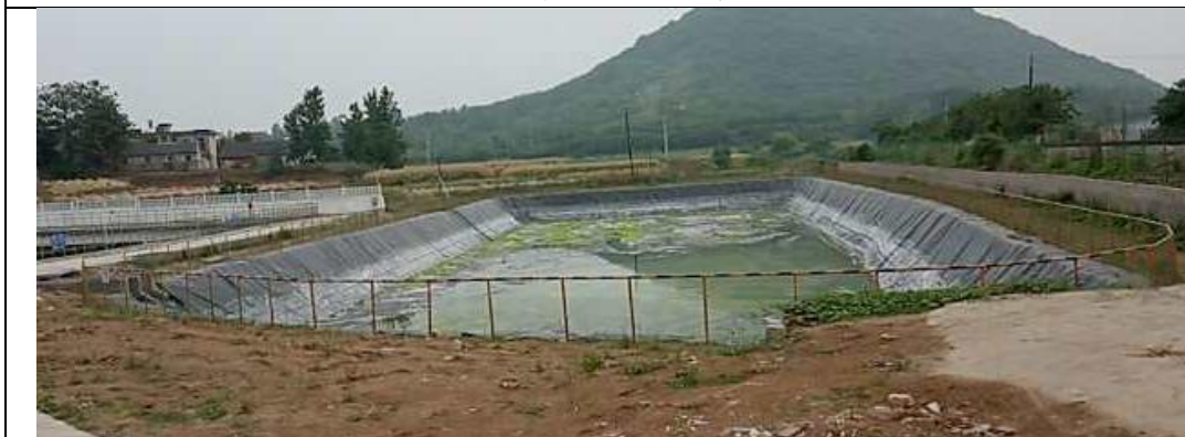
收集池防渗处理
