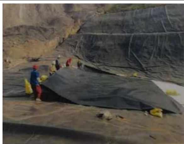
防渗膜铺设施工
