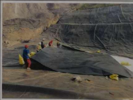
HDPE 膜的铺设
