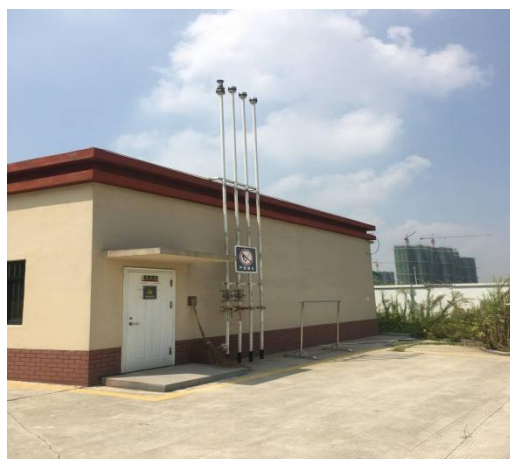
油气回收装置排放口
