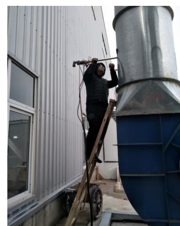
2 号活性炭吸附装置出口
