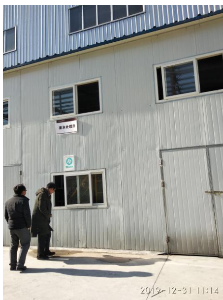
污水处理站站房
