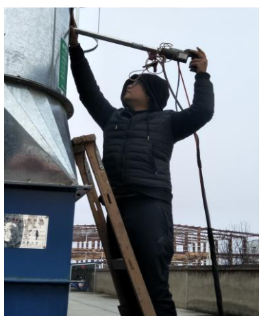
2 号布袋除尘器出口
