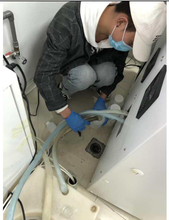
污水处理设施出口监测图片
