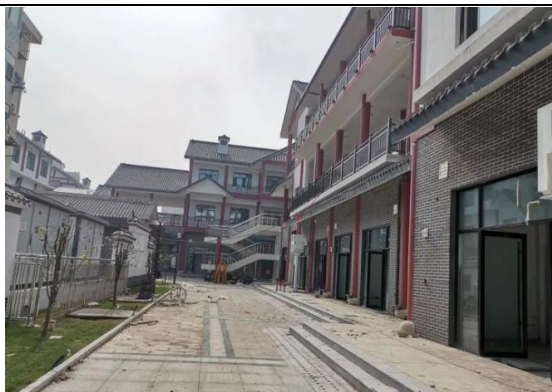
项目建设情况
