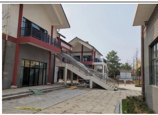
项目建设情况
