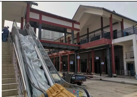
项目建设情况
