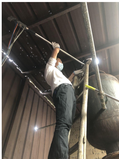
锅炉排气筒进口
