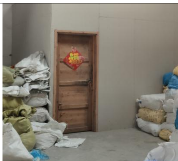
化学品仓库地面水泥硬化
