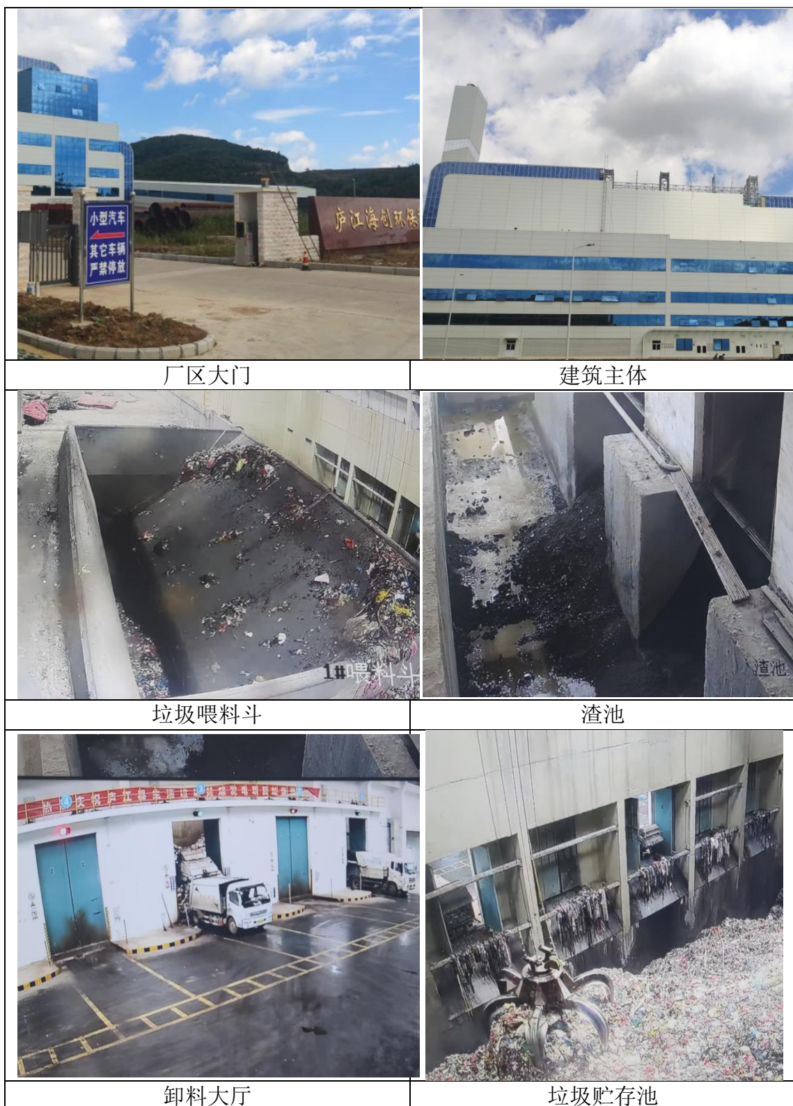
附图 8、现场勘察图片
