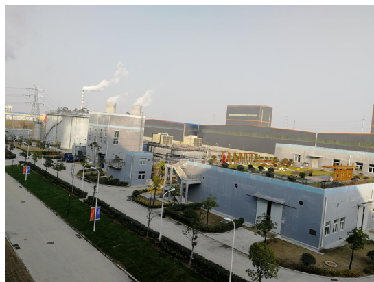
渗滤液处理系统
