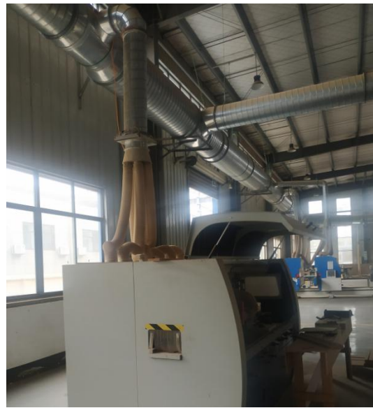
木加工车间内废气收集装置
