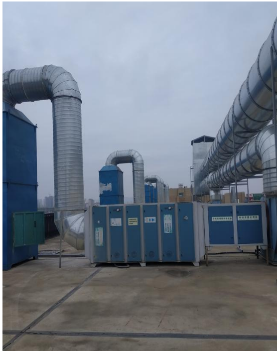
喷漆废气处理设施及排气筒
