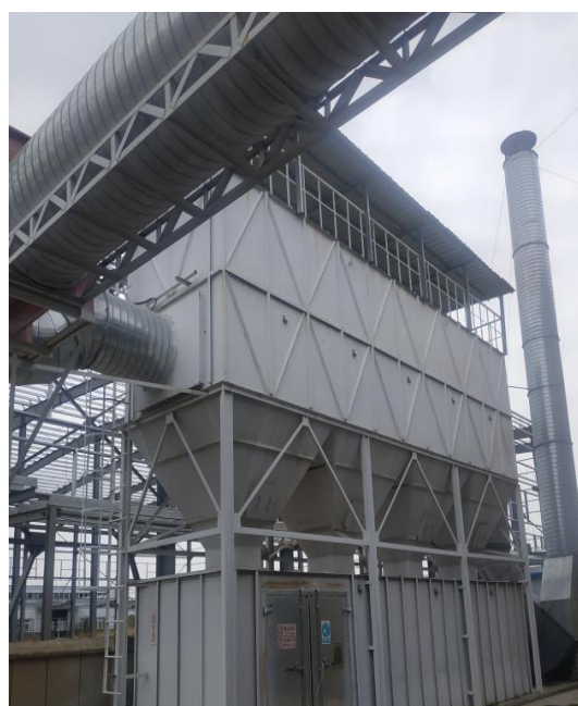
木加工车间的 2 套除尘系统及排气筒
