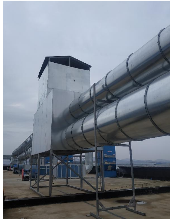
喷漆废气处理设施及排气筒
