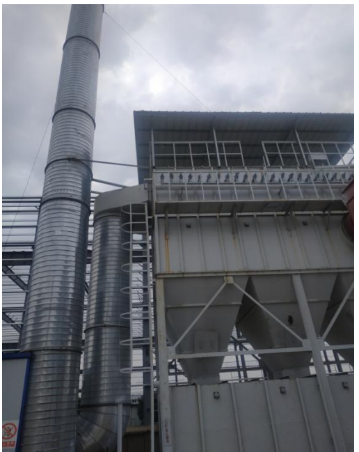
木加工车间的 2 套除尘系统及排气筒
