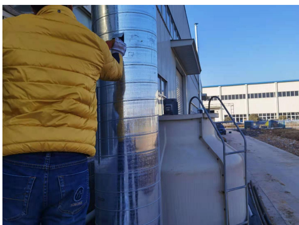
注塑废气处理设施进口监测点
