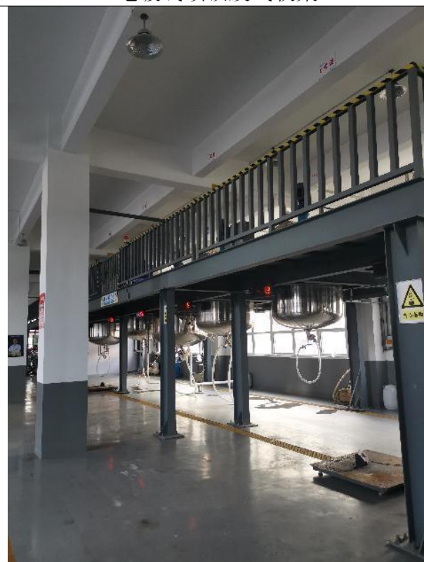
7#厂房表面处理剂车间
