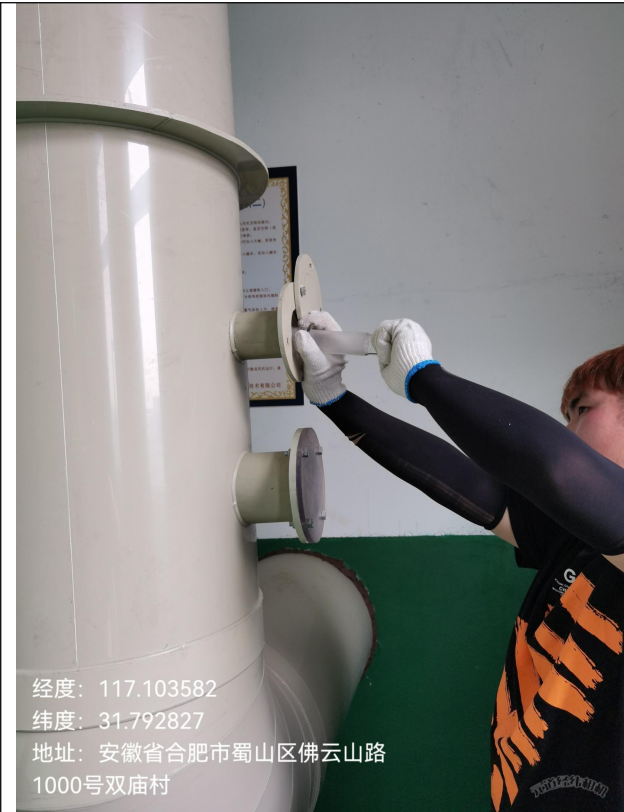
G25 危废暂存库进口
