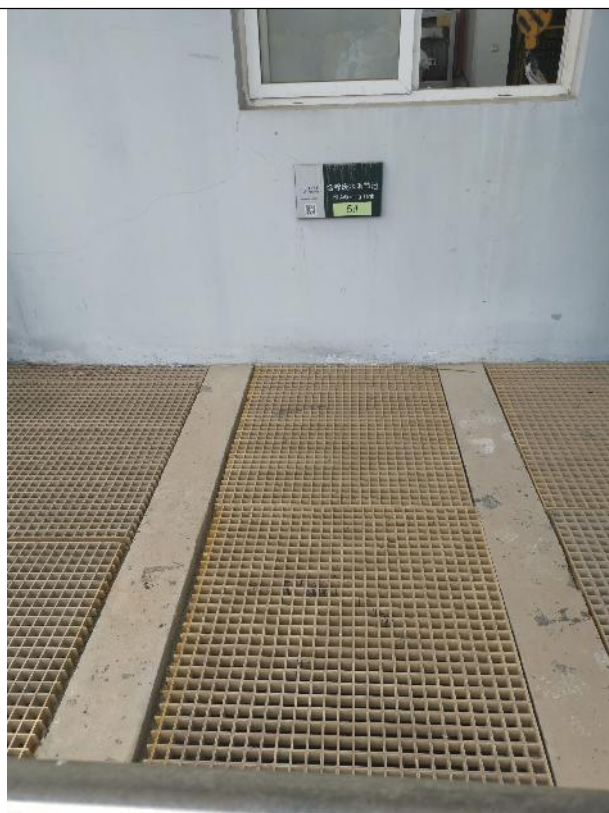
含镍废水调节池
