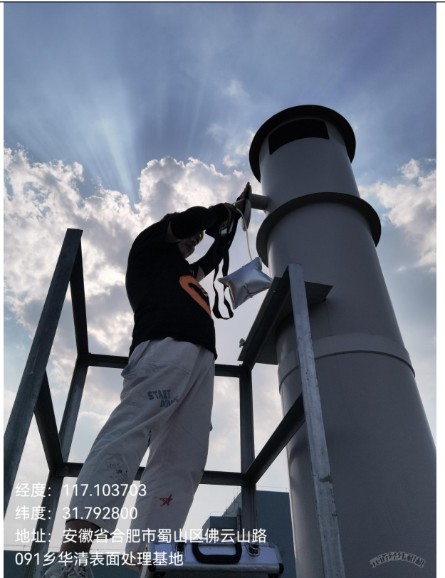
G26 危废暂存库出口
